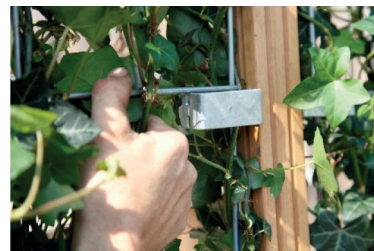
De haag kan "gehangen" worden in de uitsparing van de bovenste beugels.
