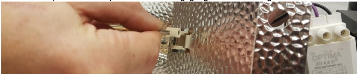
NL: Aan één zijde van de lamp is er ruimte om de lamp op deze wijze uit de fitting te nemen.
