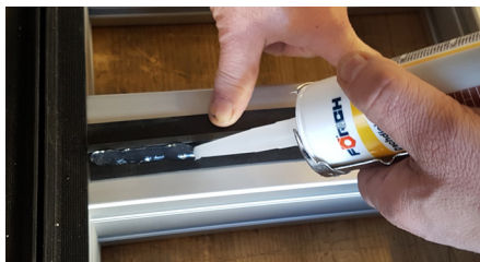
Tragen Sie eine große Menge Dichtungsmasse auf das Abstandsgummiprofil (kurze Seite der Module) auf.
