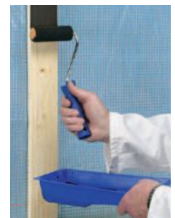
Voorbehandeling houten draagconstructie met Primer SX Black
