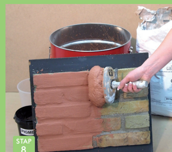
STAP 8 Kaleimortel aanbrengen.
