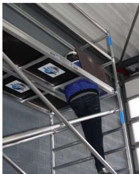
11) Lorsque l'échafaudage est à la hauteur souhaitée, placez un plancher de travail fermé. (2 plates-formes côte à côte). Vous ne pouvez travailler que sur une lieu de travail ! La plate-forme avec trappe doit s'articuler sur l'extérieur du plancher. (c'est-à-dire de l'intérieur vers l'extérieur, voir la photo).
