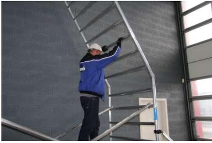
8) Placez maintenant les cadres suivants sur la section de base et montez le des diagonales (les cadres FC et Euro doivent être à un angle faible à placer sur les broches de connexion. En joignant des diagonales à partir du 2ème échelon, les deux sont construites. encadre un ensemble rigide.
