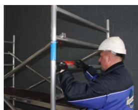
5) La section de base doit maintenant être soigneusement nivelée. ...sont revendiqués. Cela peut être fait avec le réglage de la broche sur les roues. Le maximum L'angle de la pente est de 1%.
