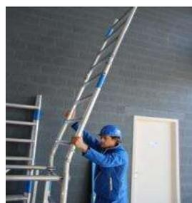
6. Legen Sie nun zwei Aufbaurahmen (1) übereinander und sichern Sie diese miteinander. Montieren Sie diese anschließend auf das Basiselement und achten Sie darauf, dass alle Aufbaurahmen mit einem Verriegelungsclips (7) gesichert werden.
