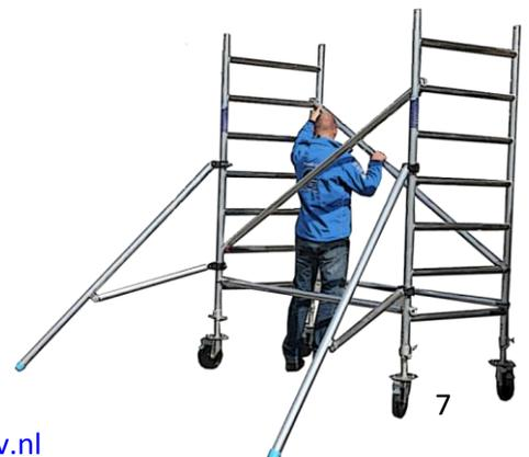
7. Der Basisabschnitt wird in die Waagerechte gebracht und, falls erforderlich, mit den verstellbaren Radspindeln ausgeglichen.
