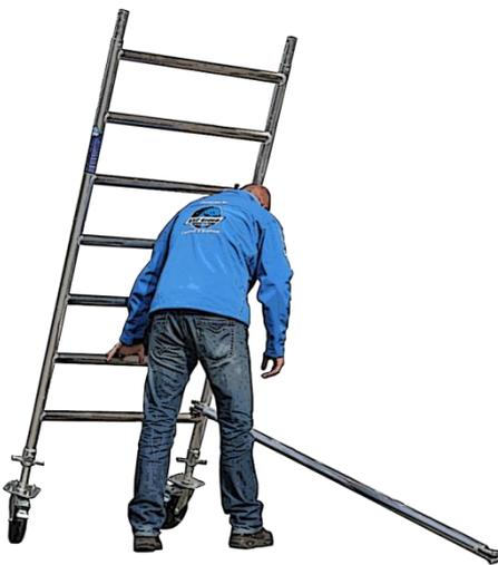
3. Horizontale Strebe an die entsprechende Seite der Stütze klicken und Strebe am Boden ruhen lassen.
