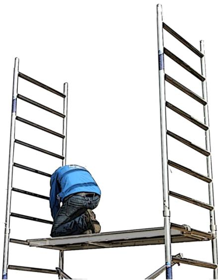
10. Jetzt die folgenden Rahmen auf dem Basisabschnitt anbringen und die diagonalen Streben montieren. Durch die Befestigung der diagonalen Streben werden beide Aufbaurahmen zur starren Einheit. Sie werden mit einem Sicherungsclip miteinander verriegelt.
