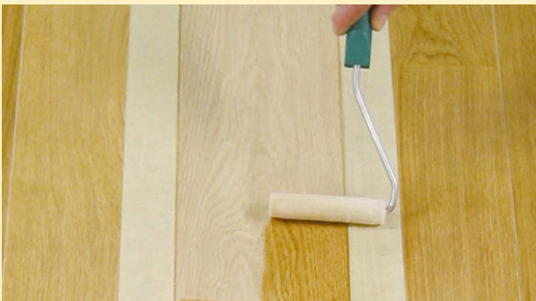
Osmo Hardwax-Olie met de microvezelroller dun aanbrengen.
