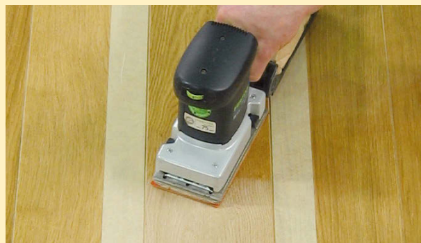
Beschadigde oppervlakken grondig schuren
