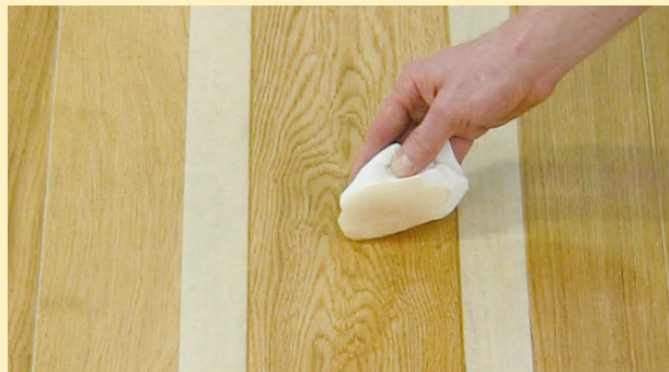
Na droging een zeer dunne tweede laag met een pluisvrije katoenen doek aanbrengen.
