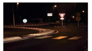
Installation: Carottage & adhésif requis (bitume à chaud, époxy bi-composant)
