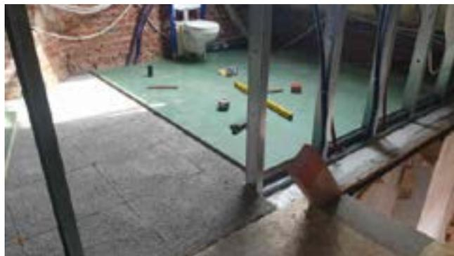
Dans le cas d'une chape isolante, la grille Staeis sert de treillis en bois facilement réglable en hauteur. Ceci vous permet de visser des panneaux OSB ou Durelis dans les lattes de la grille Staeis, que vous pouvez ensuite recouvrir avec, par exemple, un parquet multicouche flottant ou du stratifié.
