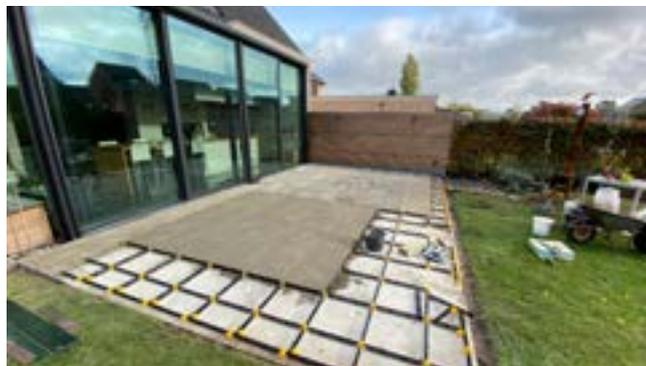
En utilisant un matériau de remplissage drainant en combinaison avec la grille Staenis, vous gardez que l'humidité et les tensions n'auront aucun effet sur la durabilité de votre nouvelle terrasse et vous optez pour une construction de terrasse correcte. Cette construction de plancher avec mortier de drainage est possible sur une dalle de béton ou une structure de plancher sur terrain plein.
