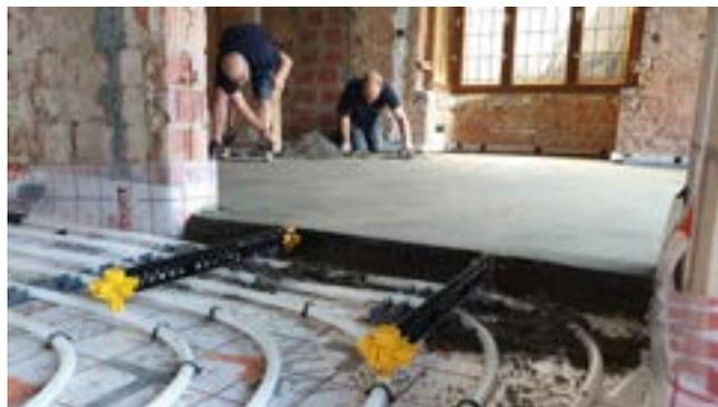
La division de la structure de plancher en très petits champs de 0,25 m<sup>2</sup> évite des problèmes tels que des fissures, un affaissement et un décollement du sol.
