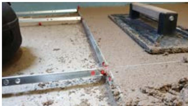
Une chape adhérente est utilisée sur une dalle de béton lorsque vous souhaitez niveler le sol entre 1 cm et 5 cm de hauteur.
