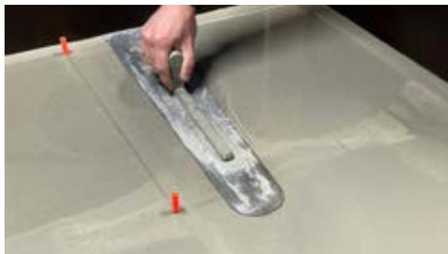
Avec la grille d'égalisation Staenis, vous réalisez de manière simple et fiable une surface plane à la hauteur souhaitée. La grille sert également de renforcement pour le substrat, protégeant ainsi mieux votre finition de sol contre l'apparition de fissures. Il est possible de réaliser une structure de plancher avec de l'égaline sur une dalle de béton ou sur un carrelage existant.
