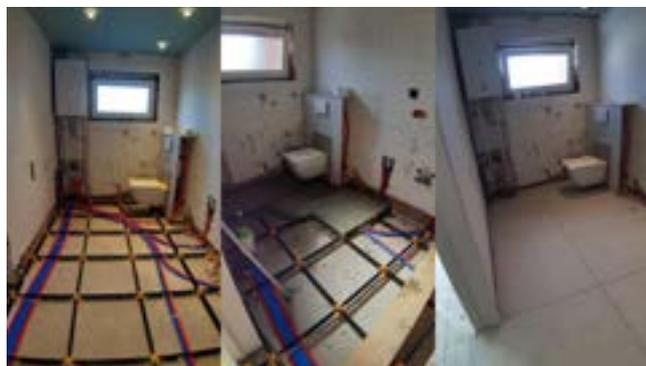
Cette structure de plancher légère est idéale pour les espaces où la hauteur de la construction du sol est limitée. Avec l'aide de la grille Staenis, il est possible d'isoler et de niveler la construction du sol, et de la finir rapidement avec des carreaux. Cela offre une solution efficace et efficiente pour créer un sol isolé. La possibilité d'appliquer une construction de sol avec une chape isolante sur une dalle de béton ainsi que sur un treillis en bois offre donc beaucoup de flexibilité.
