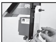
Montera höljet med hjälp av de 2 integrerade bultarna på medföljande stolpe. Denna stolpe fungerar även som jordspjut för aggregatet. För att göra detta, måste den medföljande jordkablen monteras på stolpen (läs även avsnittet Jordning).
