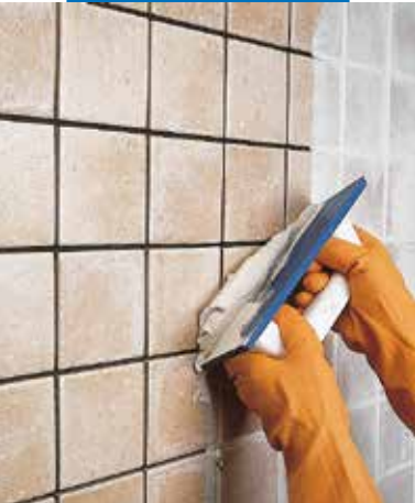
Voegen van enkelgebakken tegels met behulp van een voegrubber
