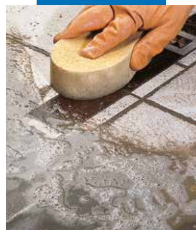
Gebruik van een spons bij het afwerken van een vloer van keramische tegels met houtinleg
