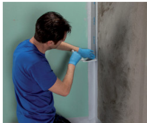
Aanbrengen van Mapeband PE 120 met Mapegum WPS
