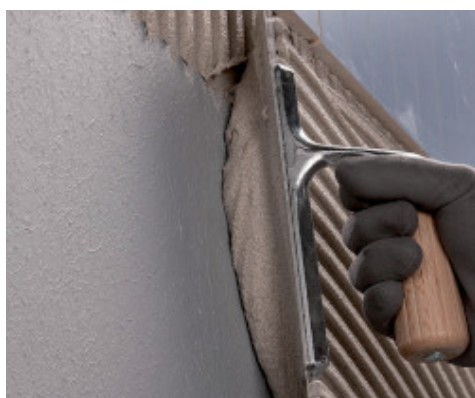
Aanbrengen van vloerbedekking met Ultramastic 5
