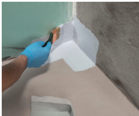
Aanbrengen van een 90° Mapeband PE 120 hoekstuk met Mapegum WPS
