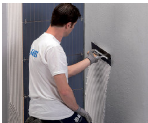
Aanbrengen van wandbekleding met Keraflex Maxi S1
