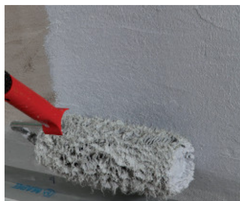
Aanbrengen van Mapegum WPS met een roller
