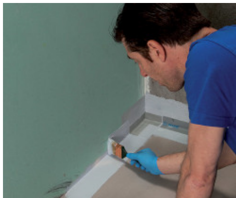
Aanbrengen van Mapeband PE 120 met Mapegum WPS
