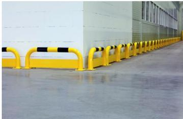
Matériaux: Tube en acier Ø 76 mm - 3 mm
