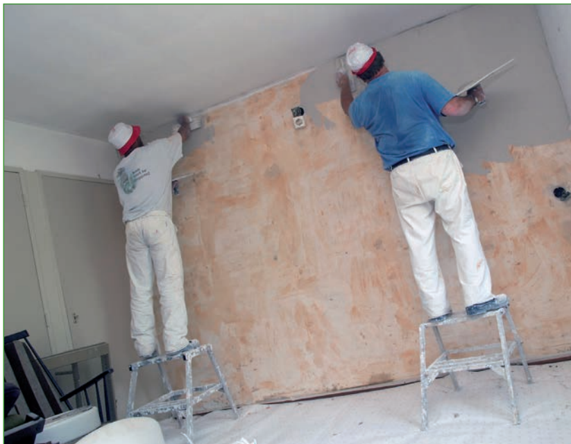
Afbeelding: zet de pleistergips op.
