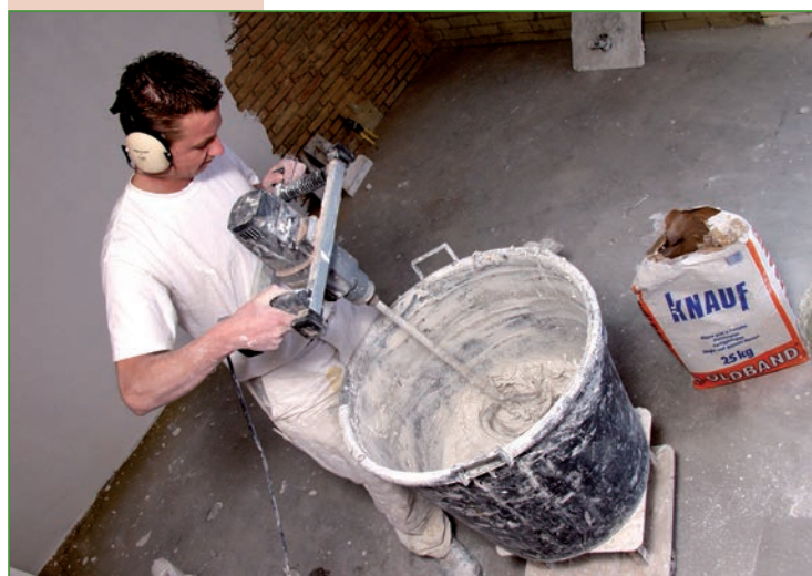
Afbeelding: mix het gips en het water met de elektrische speciemixer.
