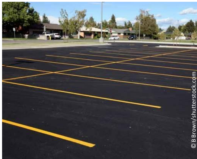
Niet waterdoorlatende parkeerplaats
