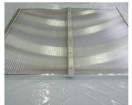
Vor dem Auflegen der Platten wird die Schutzfolie an den Längsseiten etwas gelöst.
