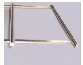
Danach werden die Unterteile des jeweiligen Profilsystems auf der Unterkonstruktion befestigt.
