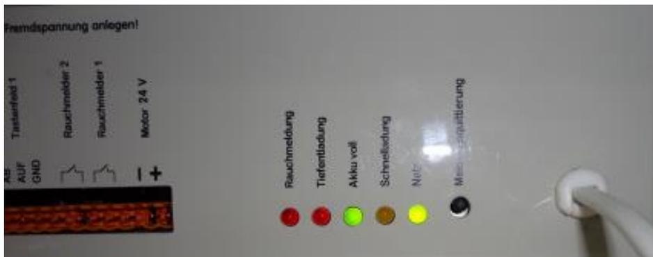
Bei Bedarf sind immer beide Akkus gleichzeitig zu tauschen. Sollte diese Einrichtung versagen kann die Scherentreppe im Notfallbetrieb (3.1.4) bedient werden.
