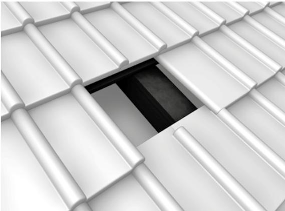
Die Sparren, auf welchen die Dachhaken befestigt werden sollen, müssen freigelegt werden. Die Auslegerhöhe des Dachhakens muss geprüft und ggf. eingestellt werden.
