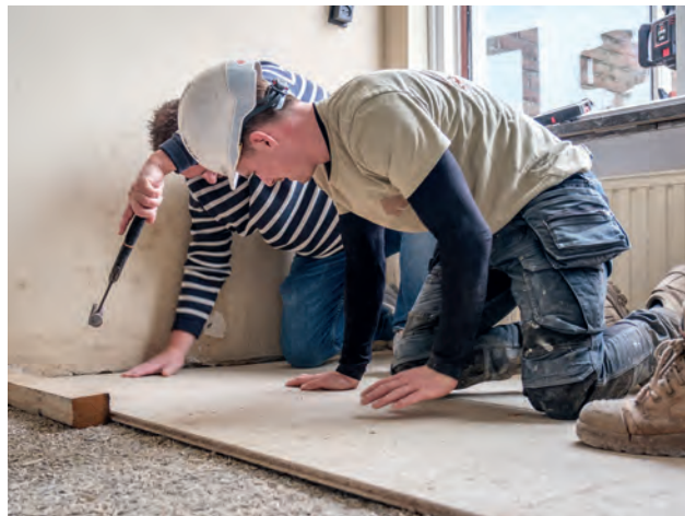
Op de kalkhennep is een dubbele laag ESB-platen aangebracht.
