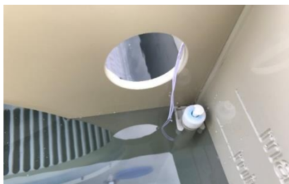
Vlotter staat in 'normale' stand, vijverpomp staat aan.
