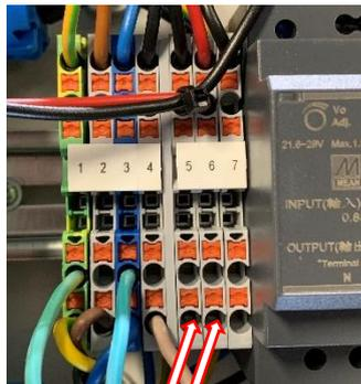
Der Float wird an 5 und 6 mit der Makoi Drum-Steuerung
