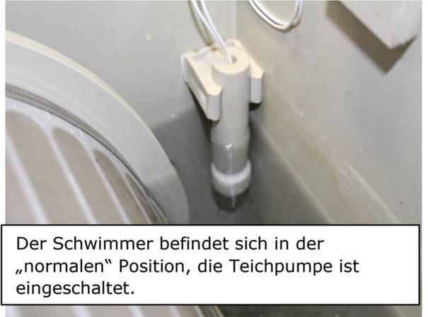
Der Schwimmer befindet sich in der „normalen“ Position, die Teichpumpe ist eingeschaltet.
