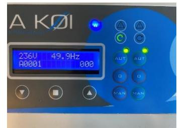
Die grünen Lichter über AUT leuchten. Das System ist scharfgeschaltet. Diese Lichter müssen immer an sein! Sie können es auch ausschalten, indem Sie die rote (n) Taste (n) drücken. Dies ist nur für Installateure. Stellen Sie sicher, dass die **grünen Lichter immer leuchten**, indem Sie die AUT-Tasten drücken.
