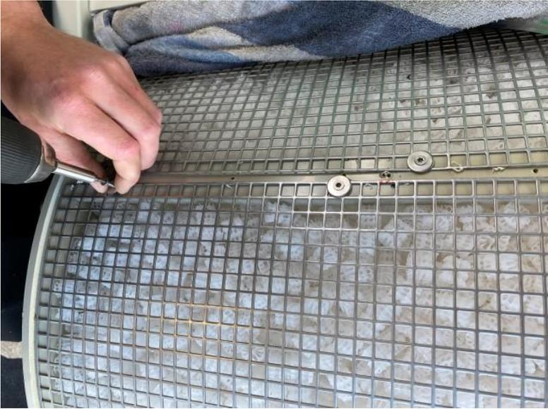
Schrauben vom Gitter entfernen
