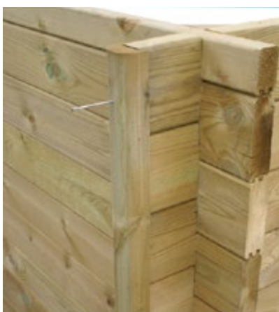
Figuur 20 – Houten afwerklijst
