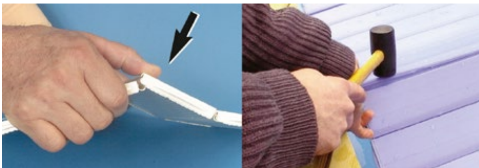
Figuur 45 – De lamellen klikken
