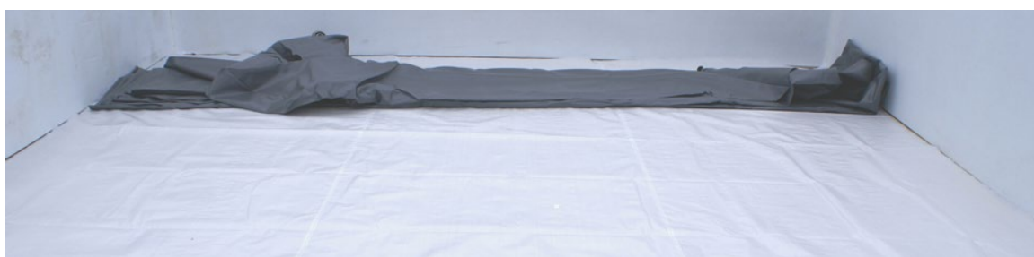
Figuur 33 – De liner uitvouwen
