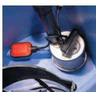
voorzien van pomp
