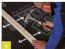
Tengellat positioneren en bevestigen
