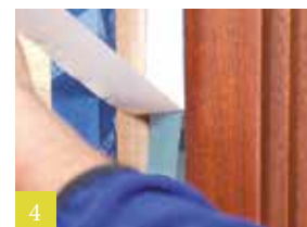
4 Raam binnen: tweede zijkant / band aanwrijven
