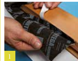
1 Aan de zijkant op het kozijn vastplakken
