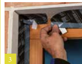
3 Raam rondom en over de hoeken verlijmen
