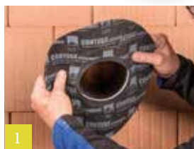
1 Manchets over de buis schuiven
