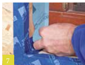
7 Gevelvenster – eerste flank verlijmen
