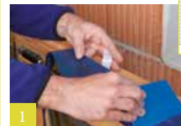
1 Band op het kozijn vastkleven
