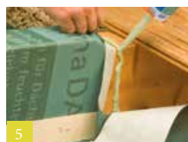
5 Aanbrengen van Sub-and-Top-baan
