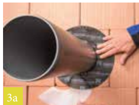
3a Met de ondergrond verlijmen
