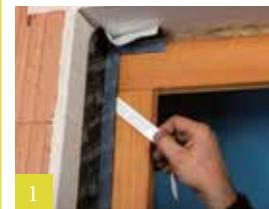
1 Op kozijn verlijmen
