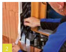
2 Met uitzettingsvouw op dagkant vastplakken
