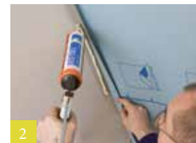
Aansluiting op gepleisterde gevelwand
