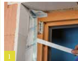
1 Op kozijn verlijmen
