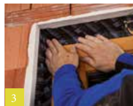
3 Over hoek vastplakken en rondom raam vastplakken
