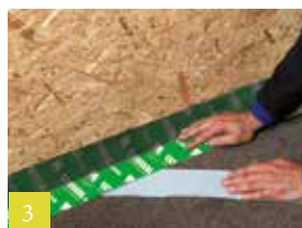
3 Op vloer vastplakken
