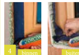
4 Band rondom in de dagkant vastkleven met ORCON F
