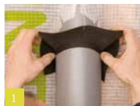
1 Manchet over de buis trekken en uitlijnen
