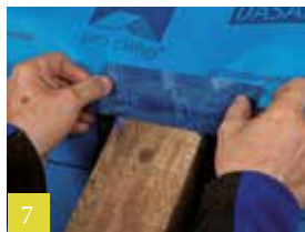
7 Vastplakken op bovenkant spant
