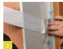
2 Met uitzettingsvouw op dagkant verlijmen
