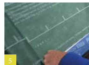
5 Aansluiting verlijmen
