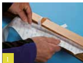
Aan de zijkant op het kozijn vastplakken
