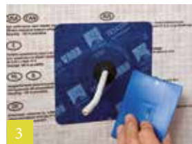
3 Manchet verlijmen en goed vastwrijven
