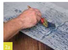
2a Gebreken in de ondergrond wegwerken
