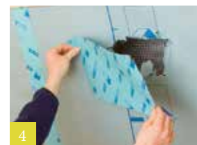
4 Detail reparatieverlijming
