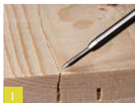
1 Problematische plekken wand
