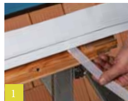
1 Aan de zijkant op het kozijn verlijmen
