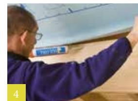
Aansluiting op ruw gezaagd hout
