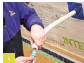
3 Kabel doorvoeren
