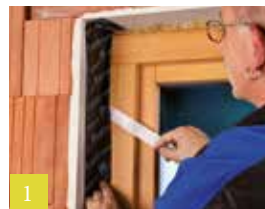
1 Op kozijn vastzetten
