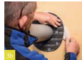
3b Met de ondergrond verlijmen
