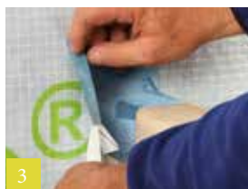
3 Rest van de afdekfolie verwijderen en op het vlak verlijmen
