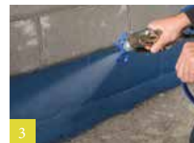
3 Spuitfolie aanbrengen (Airless-spuitmethode)
