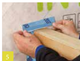
5 Aansluiting met kort kleefbeen
