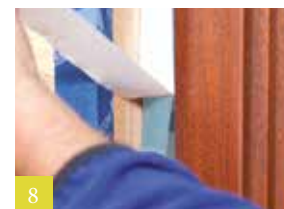
8 Gevelvenster – tweede flank verlijmen
