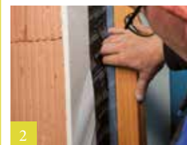
2 Met uitzettingsvoeg op dagkant verlijmen
