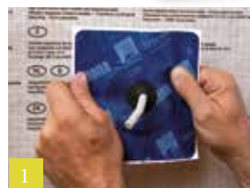
1 Kabel doortrekken en uitlijnen
