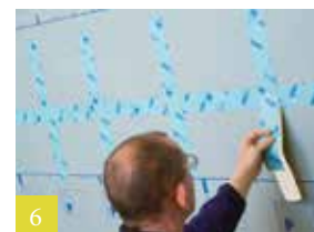
6 Detail inblaasisolatie
