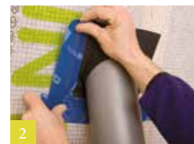
2 Manchet verlijmen en goed vastwijven
