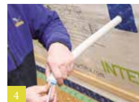
4 Luchtdicht verbinden met mantelbuis
