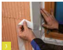
3 In de dagkant verlijmen en aanwrijven
