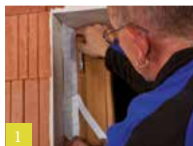
Op kozijn vastzetten
