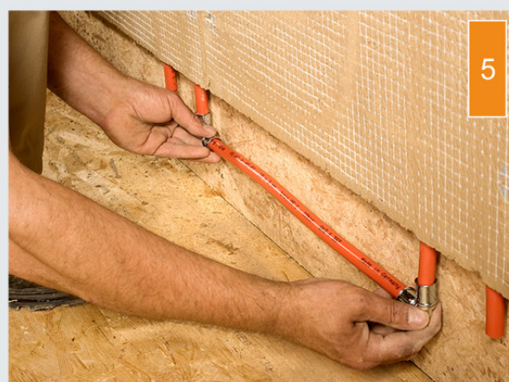
(5) De watervoerende Klimatelementen worden met een buis met elkaar verbonden ... (verder op pagina 10)
