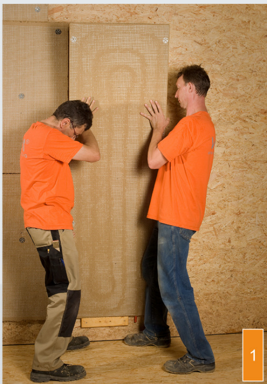
(1) De Klimatelementen worden geplaatst ...
