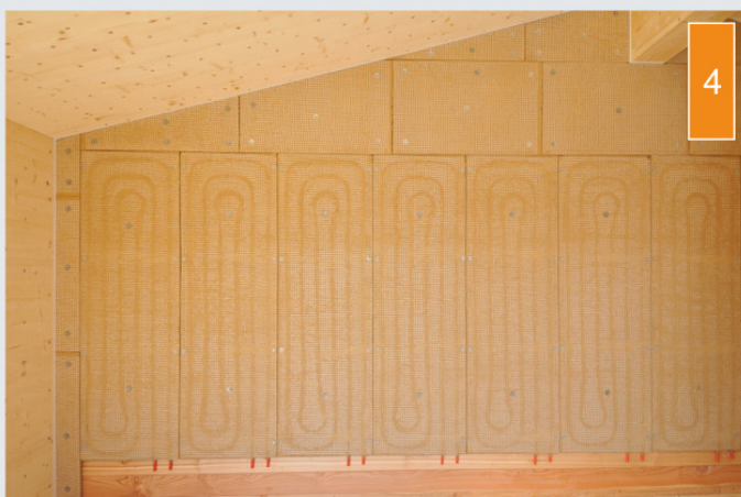
(5) De watervoerende Klimatelementen worden met een buis met elkaar verbonden ... (verder op pagina 10)
