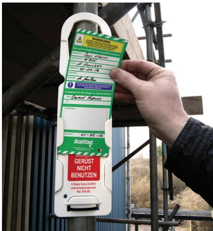
Der Scafftag-Halter wird zu Beginn des Gerüstaufbaus an allen legalen Zutrittspunkten mit Kabelbindern an Gerüststangen befestigt oder aufgehängt (der Zutritt erfolgt in der Regel über eine Leiter). Auf dem leeren Scafftag-Halter wird das Verbotssymbol mit dem Hinweis „Gerüst nicht verwenden“ deutlich angezeigt.
