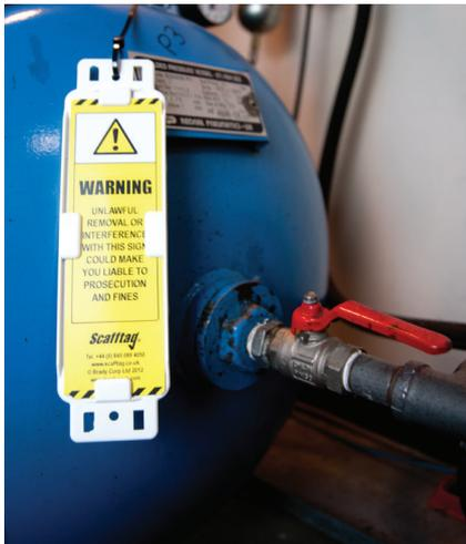
Der Multitag-Halter wird mit Kabelbindern oder Klebstoff an einer Stelle am Gerät angebracht, an der er deutlich sichtbar ist, die Bediener aber nicht stört. Achten Sie darauf, dass das Verbotssymbol mit dem Hinweis „Dieses Gerät nicht verwenden“ vor der Prüfung deutlich sichtbar ist.
