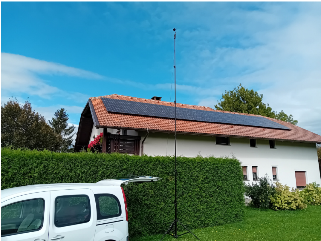
Fotografija 2: Merilno mesto MM2 in stanovanjska stavba Tržaška cesta 79
