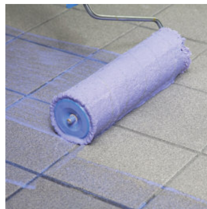
PCI Gisogrund 404 met controlekleur violet zorgt voor een goede hechting van egalisatiemortels of tegellijmen met de ondergrond.
