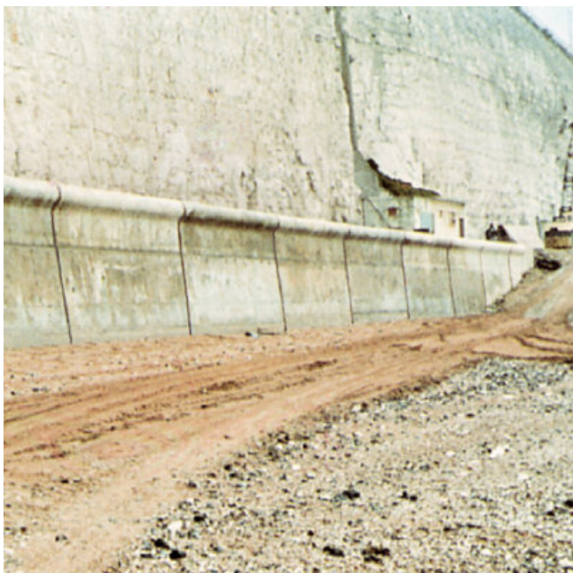
PCI Escutan TF voor het afsluiten van de voeg in een vloedmuur.
