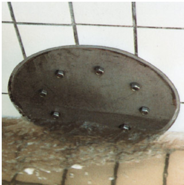
Duurzame afdichting van buisdoorvoeren met PCI Escutan TF.
