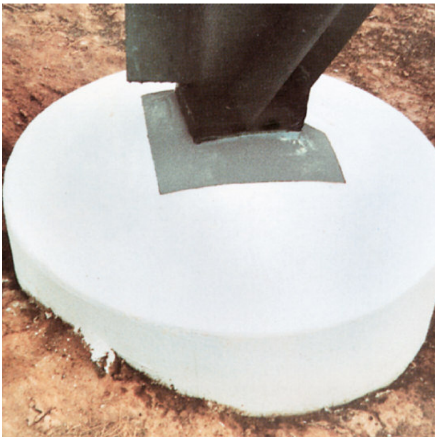
De elastische manchet van PCI Escutan TF voorkomt het binnendringen van water bij de hoeksteun in de betonfundering van een hoogspanningsmast.
