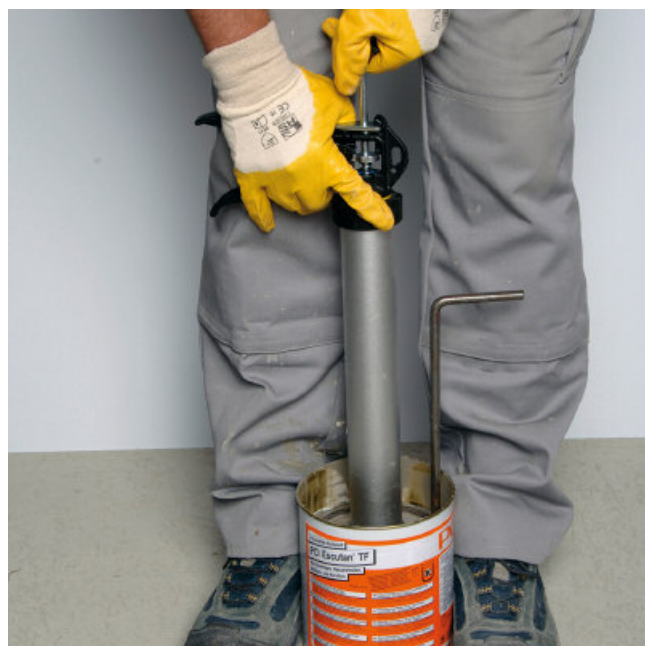
Afvullen van PCI Escutan TF in een spuit met behulp van zuigplaat.
