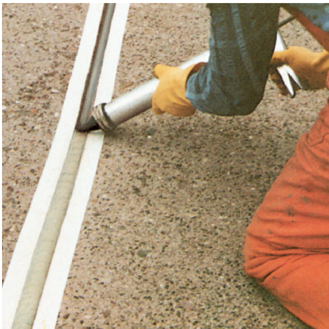
Elastisch afsluiten van een bereiden uitzetvoeg in een betonnen wegdek.
