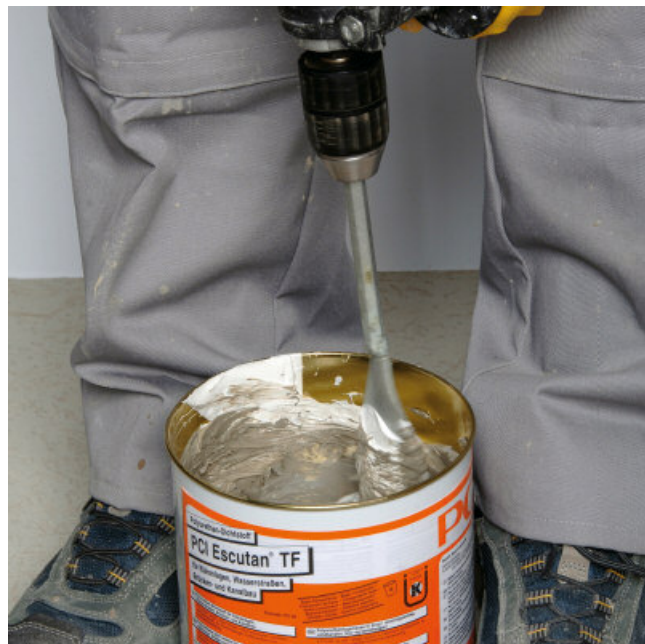
Mengen van basis- en verharder-component.
