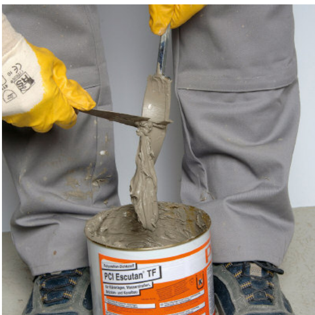
Voorreinigen van het roergereedschap.
