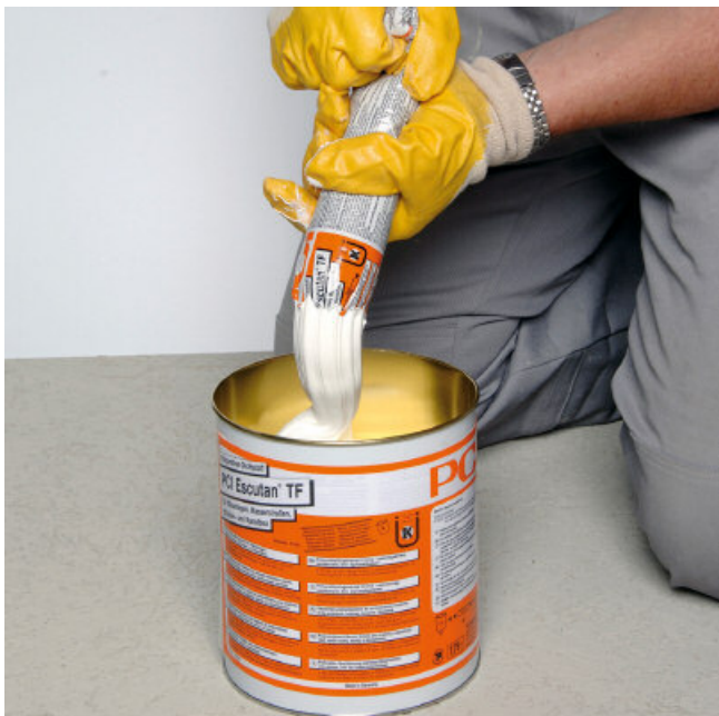
Toevoegen van de verharder aan de basiscomponent.
