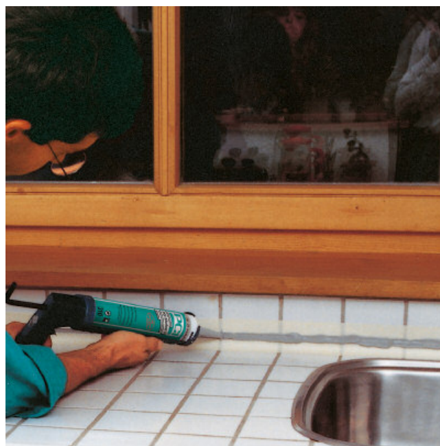
Elastisch afdichten van hoek- en aansluitvoegen van keramiek op een aanrecht.
