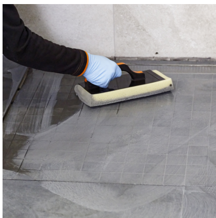
Na ca. 10 – 45 minuten het gevoegde oppervlak met een sponsbord emulgeren en dan wassen.
