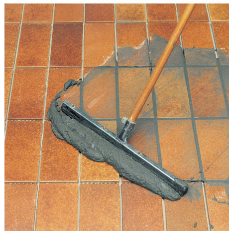
Volgende PCI FT Fugenbreit gelijkmatig in de voegen werken....
