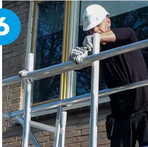
Die gesamte Konstruktion aufrecht in das Gerüst einsetzen und an der Innenseite des ersten Horizontalträgers befestigen.
