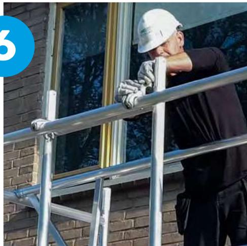
Zet het geheel rechtop in de steiger en maak deze vast aan de binnenzijde van de eerste horizontaalschoor. Bevestig met 2 koppelklauwen.
