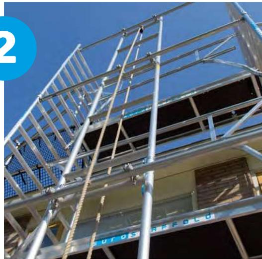
Die nächsten Horizontalträger alle 2 Meter darüber montieren. Der obere Horizontalträger befindet sich auf der oberen Sprosse des höchsten Aufzugsrahmens.
