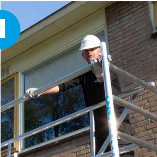
Den unteren Horizontalträger 3 Meter über Bodenniveau montieren.
