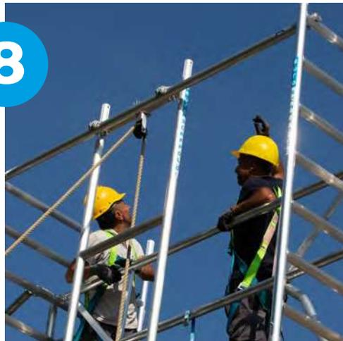
Monteer het laatste deel als de gewenste hoogte is bereikt en koppel deze met de borgclips. Koppel hier de katrol aan het bovenste liftframe. Zorg dat de lijn door de toprol is gehaald voor montage van het bovenste liftframe.
