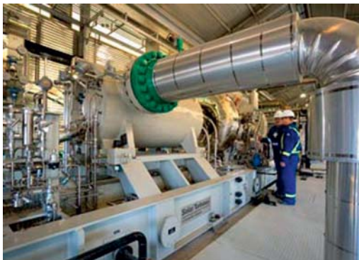
Installatie van Solar Turbines
