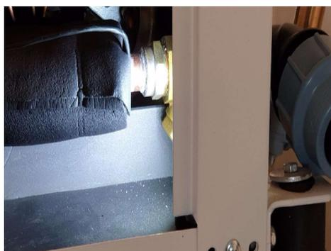
Déplacez le manchon d'isolation vers l'arrière pour couvrir le capteur et acheminez le câble vers le contrôleur.
