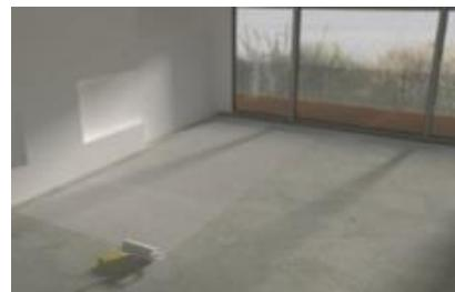
Maak de ondergrond schoon en egaal, daar waar de folie wordt geplaatst. Het is verplicht om isolatie te plaatsen onder de vloerverwarmingsfolie. Quality Heating heeft diverse isolatie mogelijkheden. Ga naar de webshop of neem contact op met de klantenservice. Heeft u een vochtige ondervloer, gebruik dan de FastHeat floor primer als voorstrijkmiddel.
