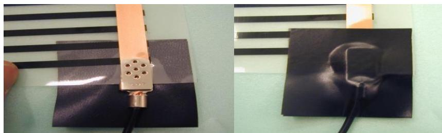
**Nach der Installation. HINWEIS :** Isolieren Sie die Crimpanschlüsse immer. Schneiden Sie 2 Stücke Isolierband ab und kleben Sie diese auf beiden Seiten über die Crimpverbinder. Das Klebeband muss weit über das Ende des Crimpverbinder gelegt werden, mindestens 5 mm. Auch das Ende der Fußbodenheizfolie sollte mit Isolierband isoliert werden.
