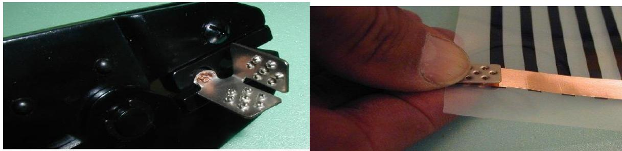
Als de complete vloeroppervlakte belegd is met de Quality Heating vloerverwarmingsfolie, dan kunnen de voedingsdraden worden aangesloten. Klem de krimpconnector vast d.m.v. de druk/krimp tang (foto boven). Let op: bij een enkele voedingsdraad (1e connectie) altijd de kerndraad dubbelvouwen! Knijp altijd aan beide zijden van de connector aan de bedrading vast. Plaats vervolgens de krimpconnector over de koperen geleider op de verwarmingsfolie. Knijp de druk verdeeltang goed dicht.
