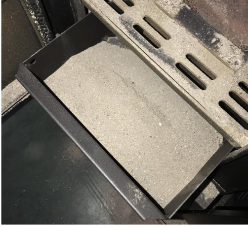
Beispiel für einen verschmutzten Aschenkasten Beispiel für einen sauberen Boden
