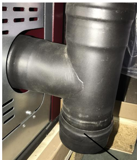
Beispiel für eine verschmutzte Abdeckung Beispiel für eine saubere Abdeckung
