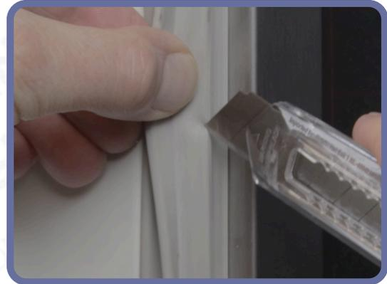
Schneiden Sie vorsichtig  $\pm 15$  cm bei Außen- und Innenseite der Dichtung mit einem Cuttermesser auf.
