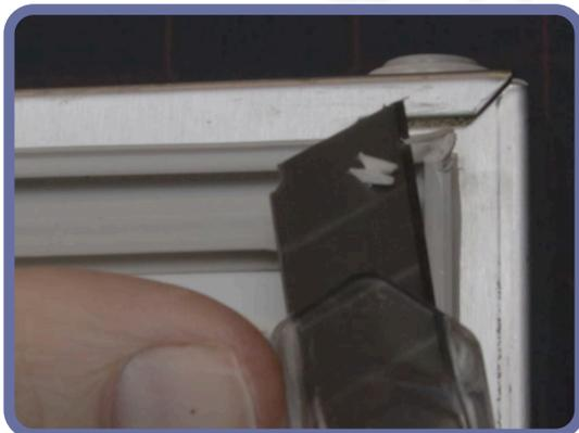
Schneiden Sie den Wulst an den Kanten ab. Dies verhindert Beschädigungen an der Türdichtung.
