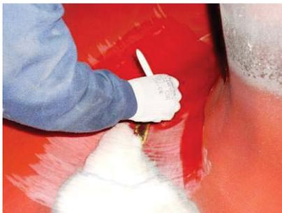
Tragen Sie eine gleichmäßig dünne Schicht "LUIWIREP PU- und Metallprimer" auf die aufgeraute Fläche auf und lassen den Haftvermittler ca. 20 Minuten ablüften\*.
