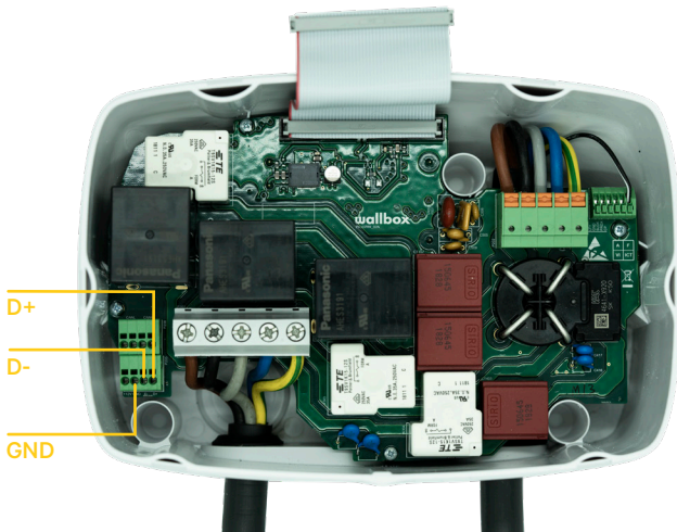
Fig. A1.6 Instalación de cableado para un Wallbox Commander 2
