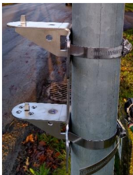
Figuur 10: montagestuk en beugels, zijzicht
