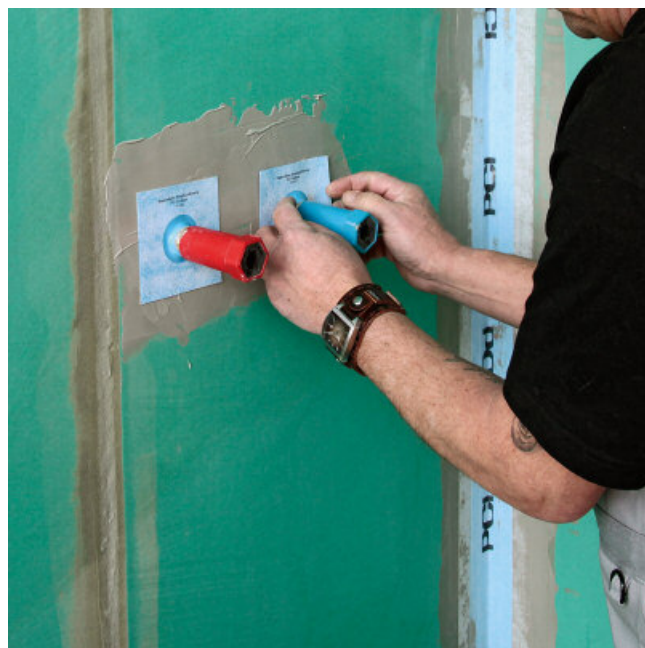
2. PCI PECITAPE 10 x 10 over de uit de wand stekende leiding schuiven en met PCI LASTOGUM (grijs) verlijmen.
