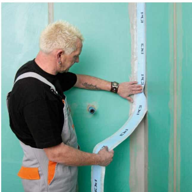
3. PCI PECITAPE 120 of PCI Kimband met PCI LASTOGUM (grijs) in de hoek- en wand/vloeraansluitingen lijmen.
