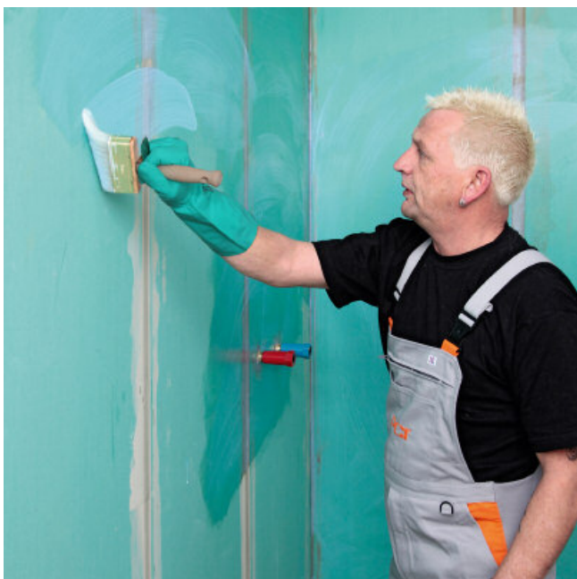
1. Zuigende minerale en gipshoudende ondergronden en gipsplaten met PCI GISOGRUND grondieren.
