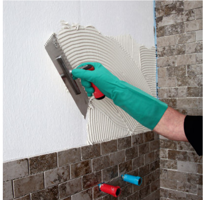
6. Na droging van PCI LASTOGUM kunnen tegels worden verlijmd.
