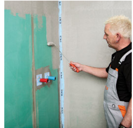
Vervolgens afdichtingsmateriaal erover smeren of spachtelen.
