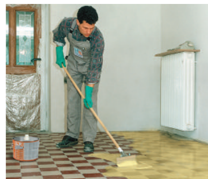
PCI Gisogrund 303 is een goede hechtprimer voor het verlijmen van keramiek of natuursteen op oude tegels.
