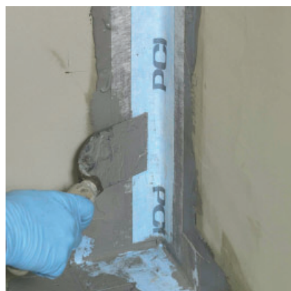
De kimband PCI PECITAPE in de hoeken aanbrengen.
