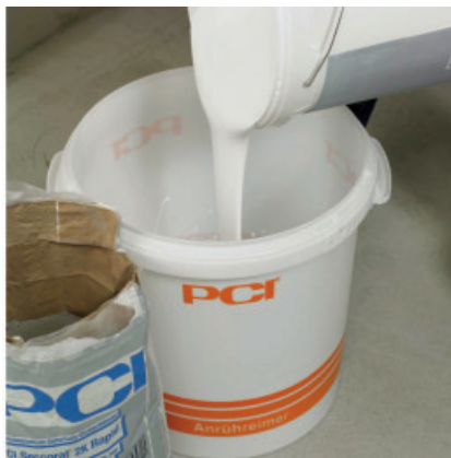
PCI SECCORAL 2K RAPID vloeibaar component in een schoon mengvat doen.
