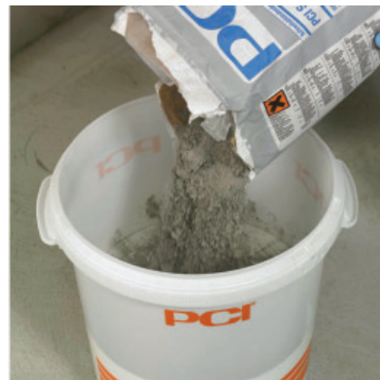
PCI SECCORAL 2K RAPID poedercomponent toevoegen.
