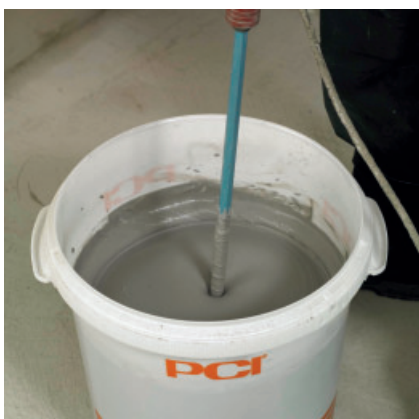
Voor het aanbrengen d.m.v. spachtelen tot een homogene pasta mengen.
