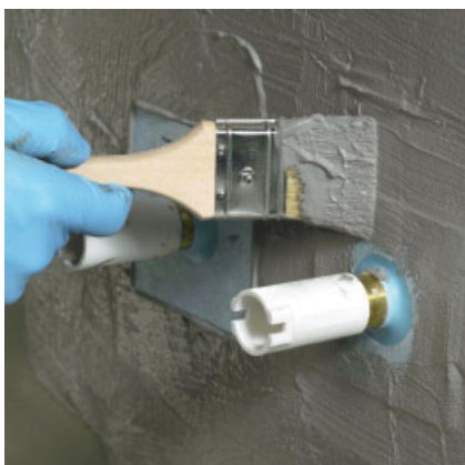
De dichtmanchet PCI PECITAPE 10x10 cm inbedden.
