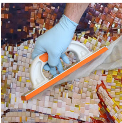
PCI Durapox® Premium Harmony met een Volrubber voegspaan in de voeg aanbrengen.
